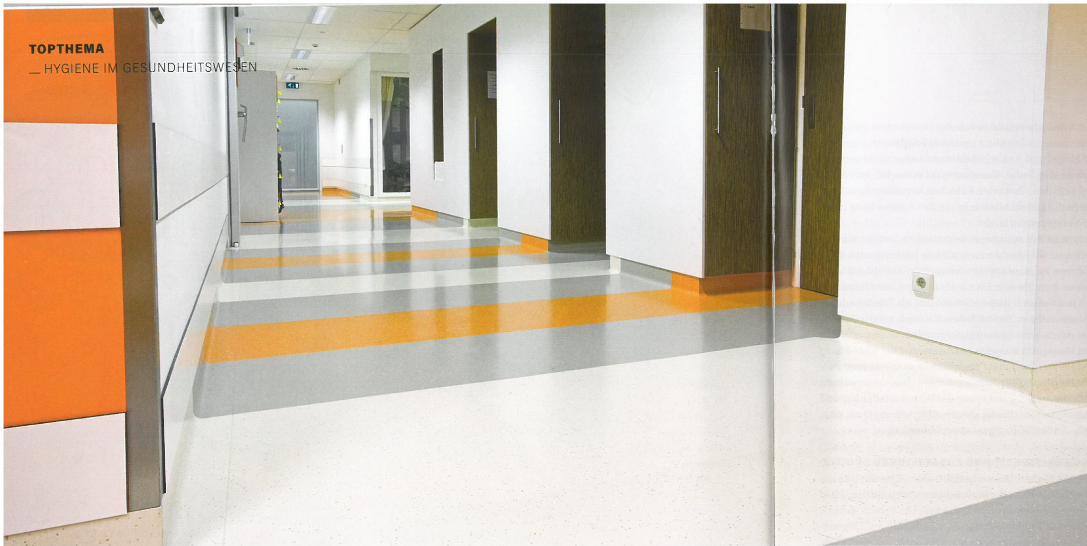
UMC-Krankenhaus in Utrecht: Mit einer PU-Versiegelung ausgerüsteter Boden.
