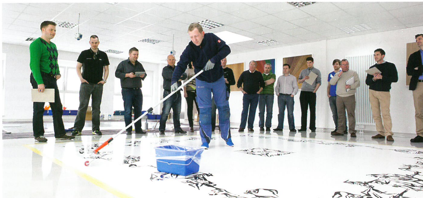
Manuel Mathes in der Schulungsakademie beim Auftrag von PU Siegel mit Folientechnik
